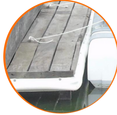
Acondicionamiento de muelle (6mts. debotazo + fijaciones)
